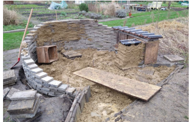
▲ Bijenburcht in aanbouw in de stadstuin Kanaalweg (foto: Bijenhoudersvereniging Utrecht eo)
